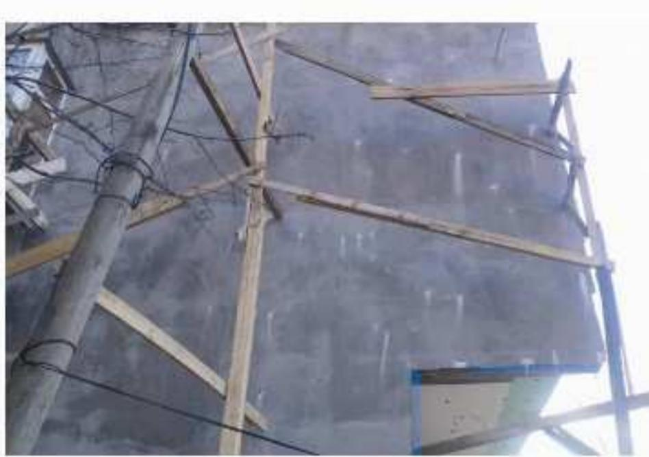
Şekil 5 - Sıva üzerinde çiçeklenme görüntüsü, EPS ve XPS kullanımı, köşe profili kullanılmaması. Hatalı iskele uygulaması.
